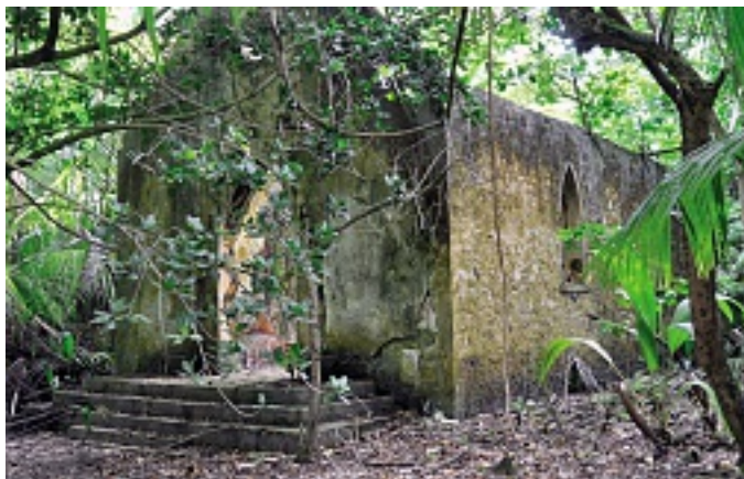
Von der Kirche stehen nur noch die Wände aus Korallenziegeln.
